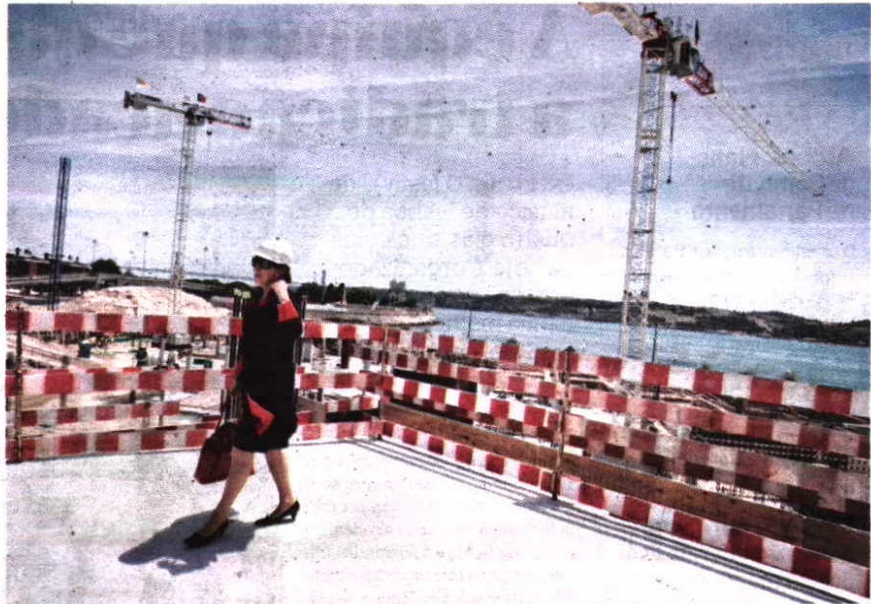
A presidente da Fundação Champalimaud, Leonor Beleza, mostrou o andamento das obras
